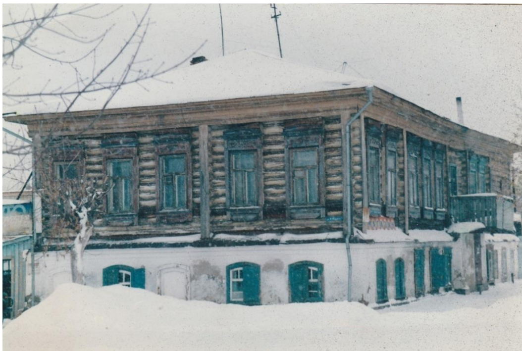
Здание школы-интерната по ул. Уральской, 14
