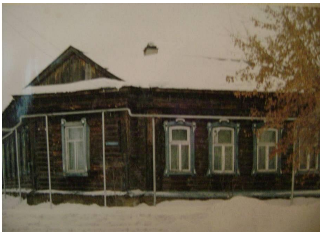
Здание спального корпуса школы-интерната № 11 на углу улиц Уральской и Пионерской.
